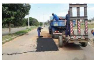
QMS 60, incluindo o recapeamento das áreas em que o asfalto se encontrava degradado.
