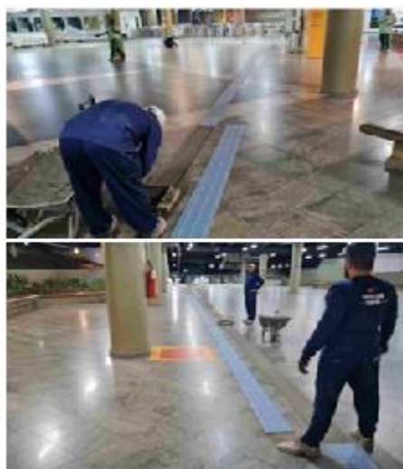
Instalação de pisos táteis
