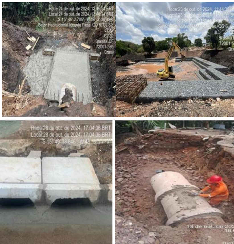
Contrato nº 29/2023 - Infraestrutura no Vicente Pires
