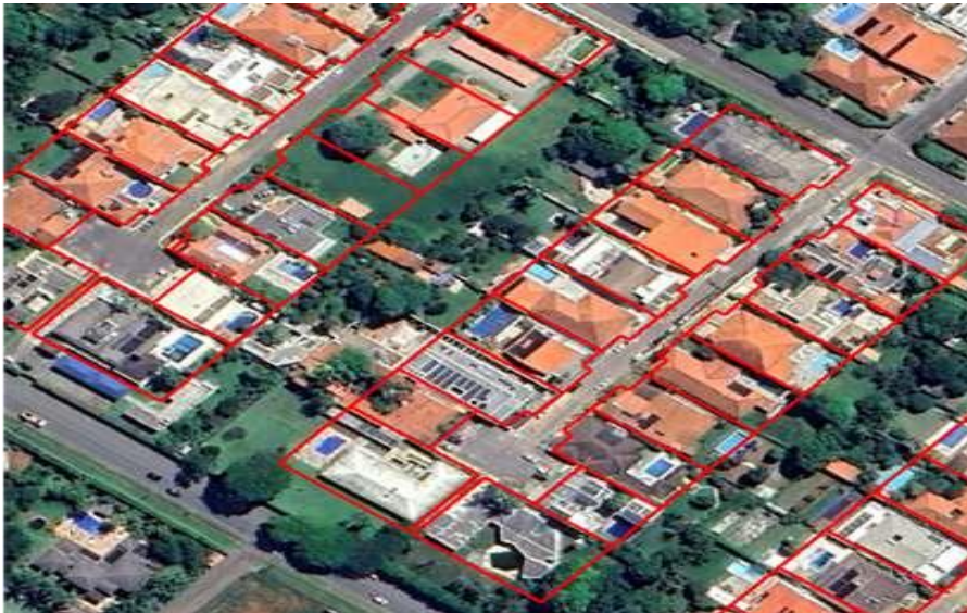
Construções em área pública na QI 15, cj. 10 a 14 do do Lago Sul
