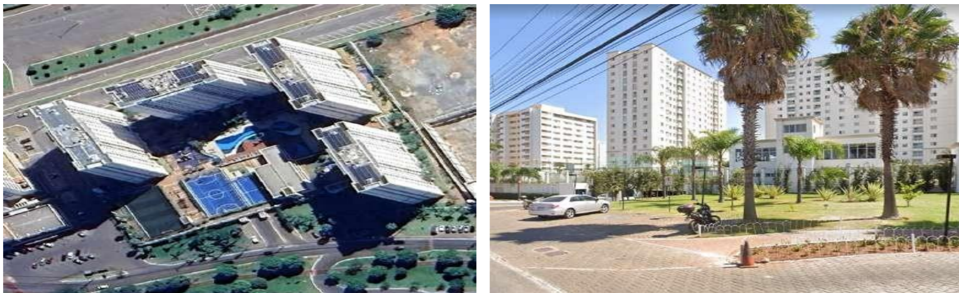
Fig. 17: Empreendimento Residencial Centro Urbano - Samambaia Fonte: Imagem aérea Google Earth de 29/05/2023 e foto do Google Street View agosto de 2021
