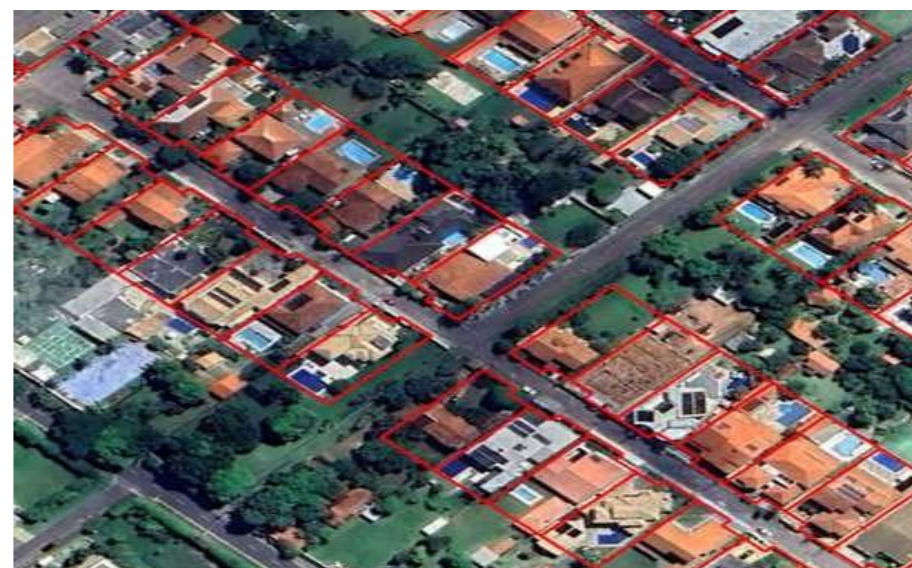
14 Construções em área pública na QI 06 , cj. 5 a 10. Lago Norte
