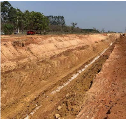
Figura 55. Manutenção da rede do emissário da Seara Alimentos. Fonte: Seara Alimentos, 2025.
