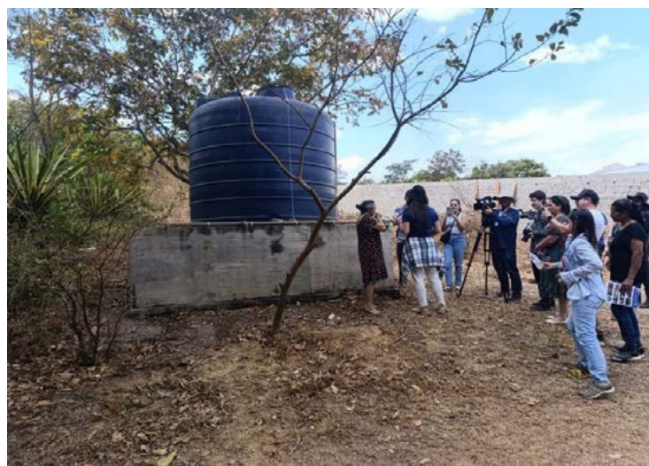
Figura 62. Caixa d'água instalada pela Caesb na Comunidade Cerâmica.
