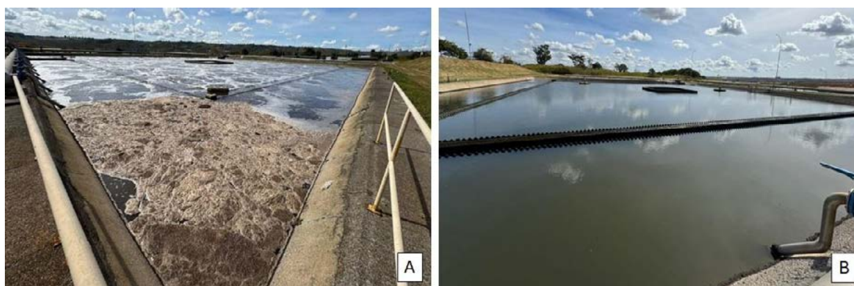
Figura 31. A) Lagoa de tratamento biológico com aeração; B) Lagoa de tratamento biológico sem aeração.
