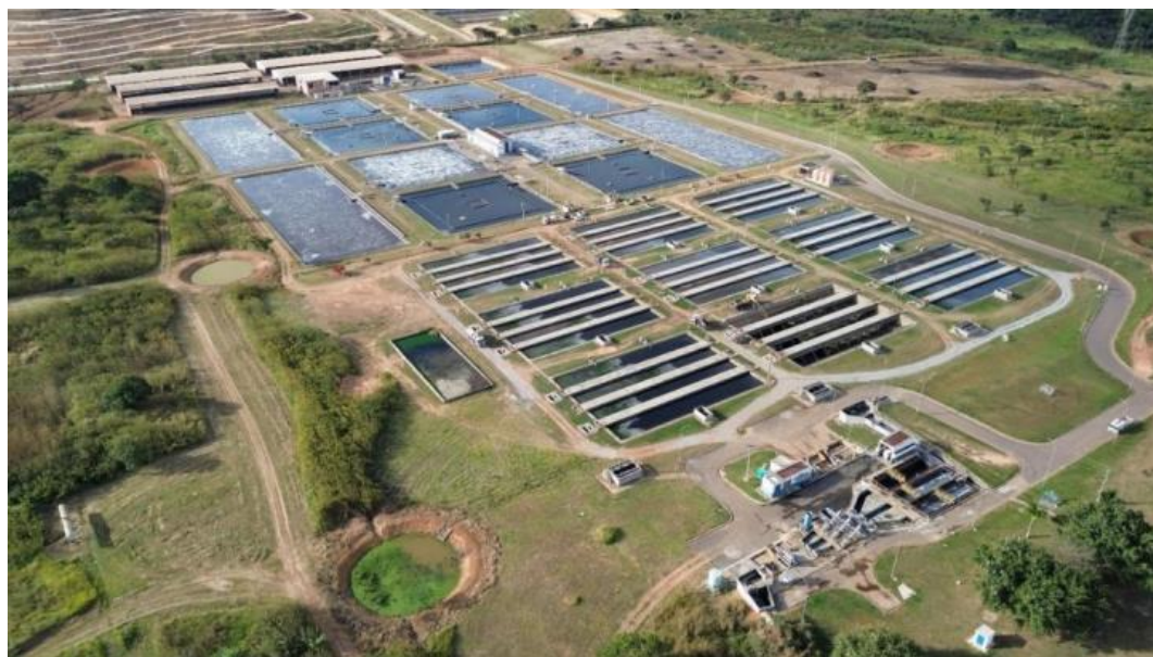
Figura 27. Vista da Estação de Tratamento de Esgoto Melchior. Fonte: CAESB.
