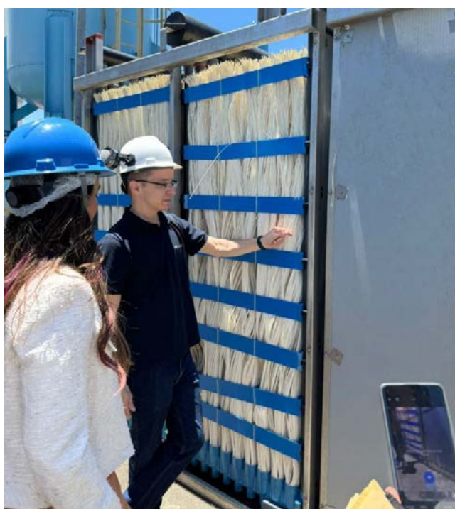
Figura 71. Membrana de ultrafiltração da Empresa Aquapolo.
