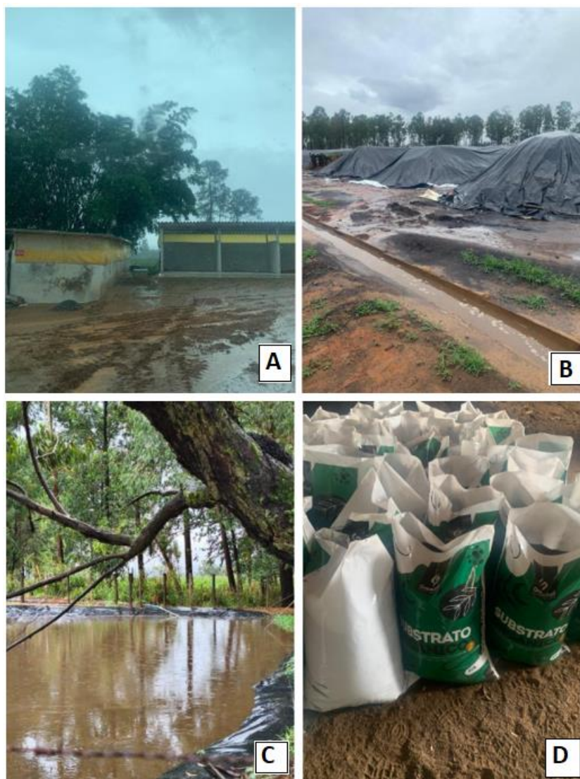
Figura 85. (A) Composteira para a recepção dos animais mortos; (B) área de compostagem da palhada utilizada nos galpões; (C) lagoa de estabilização; e (D) composto orgânico produzido na empresa.
