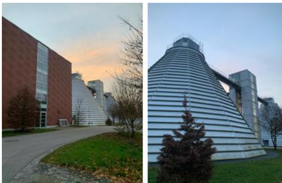
Figura 81. Biorreatores e usina de biogás da Estação de Tratamento de Esgoto de Munique.
