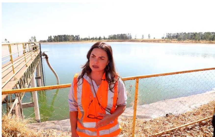
Figura 57. Reservatório para armazenamento de água, com capacidade para 360.000 m 3 .
