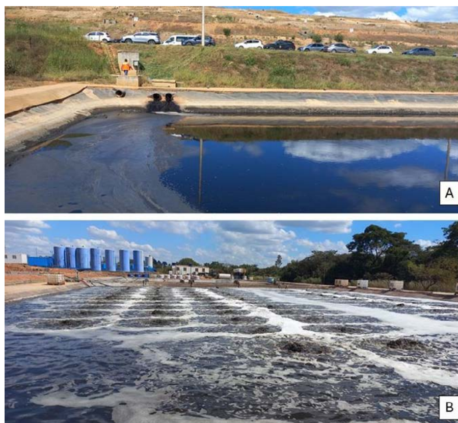
Figura 45. A) Lagoa de equalização, para recebimento e descanso do chorume; B) Lagoa de aeração.
