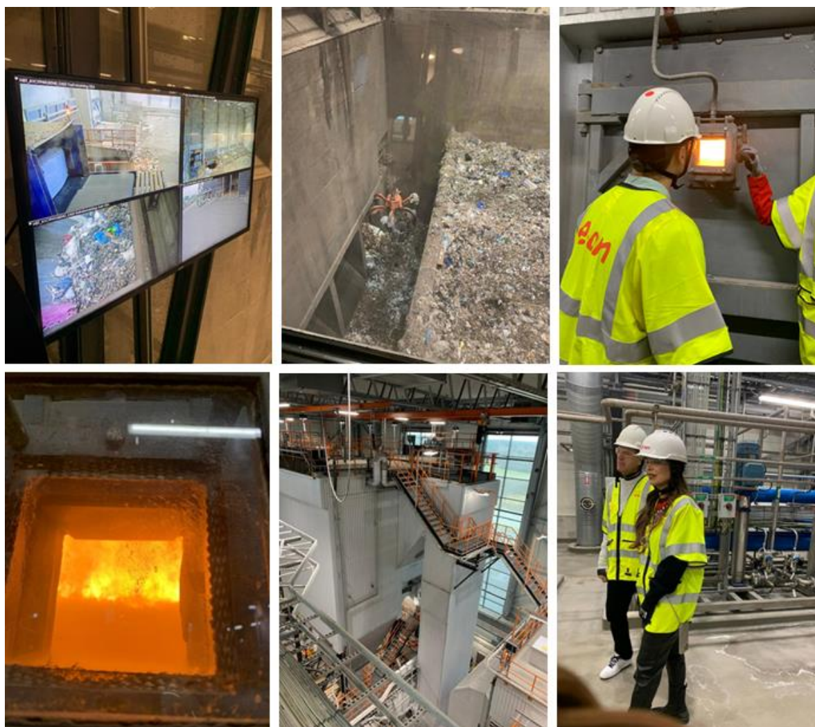
Figura 75. Instalações da unidade de aproveitamento energético e térmico da E.on - Estocolmo (Suécia).
