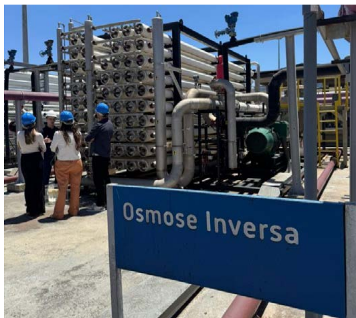
Figura 70. Equipamentos de osmose reversa/inversa da Empresa Aquapolo.
