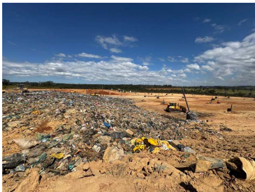
Figura 44. Frente de operação do Aterro Sanitário de Brasília – recebimento e compactação de resíduos.
