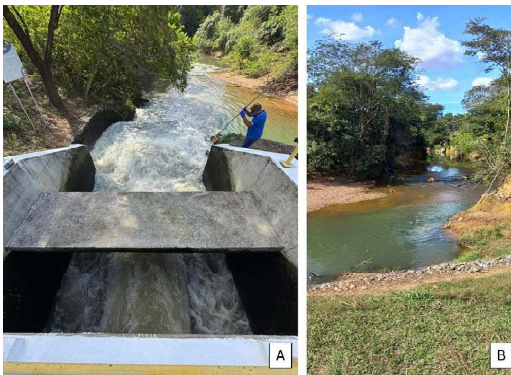
Figura 34. A) Emissário de lançamento do efluente tratado no Rio Melchior; B) Rio Melchior a montante do lançamento.
