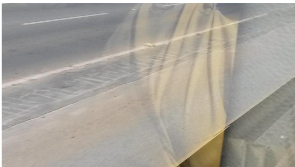
Foto x – Via EPAR - trecho com “trilha de roda” e depressões.
