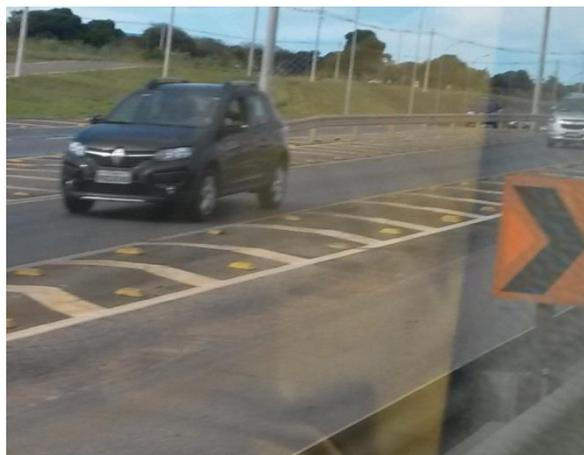
Foto 6 – Via Epar sentido Aeroporto – trecho de pista executado em CBUQ.
