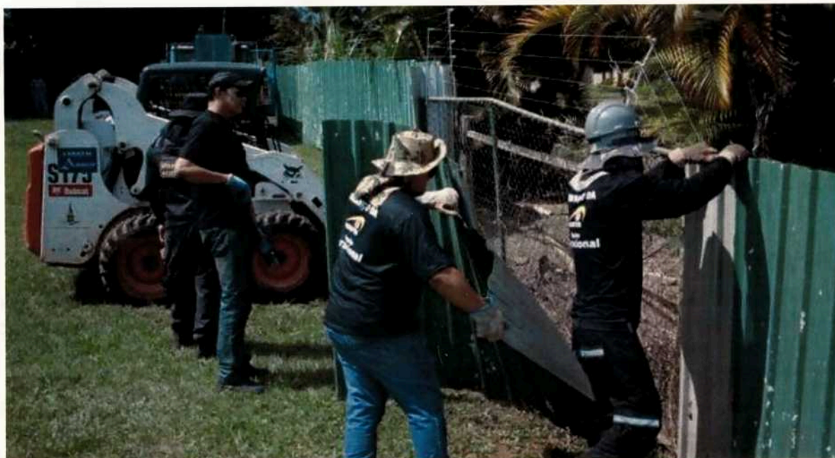
(Desobstrução da Orla do Lago Paranoá)
