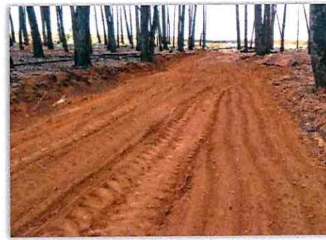
Sulco erosivo Na Floresta Distrital dos Pinheiros Nivelamento do trecho sobre os sulcos erosivos
