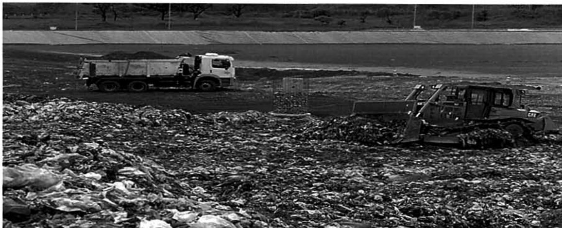
Foto 9: Aterro Sanitário de Brasília. Detalhes: compactação de resíduos, dreno de gases e material para cobertura. Ao fundo, manta protetora da célula de aterramento.
