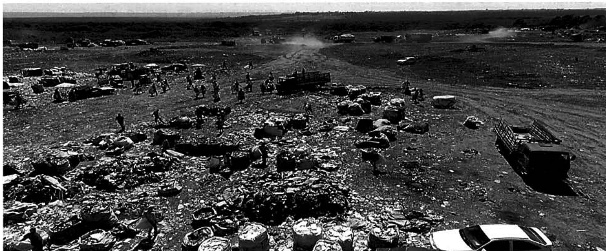
Foto 5 – Vista aérea do Aterro Controlado do Jóquei
