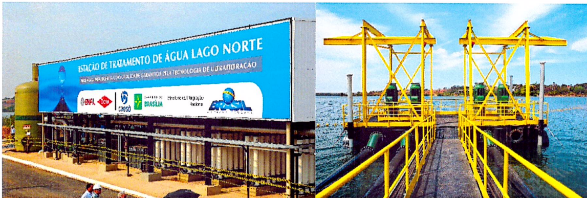
Estação de Tratamento de Água do Lago Norte
