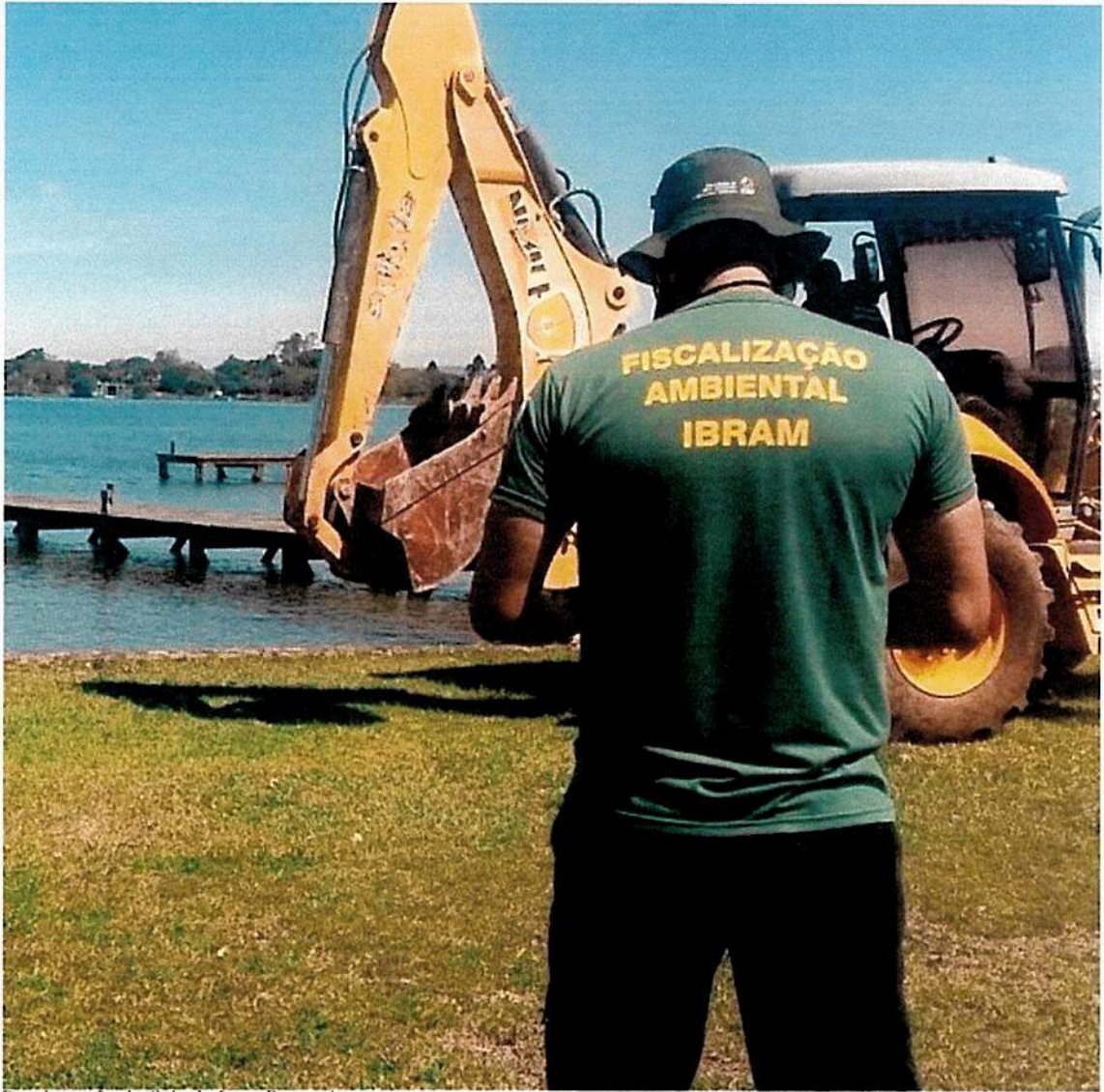
Desobstrução da Orla do Lago Paranoá
