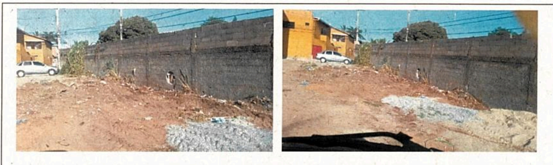
Operação Tapa Buracos, no acesso da Chácara Buritis à Avenida Canela de Ema.
