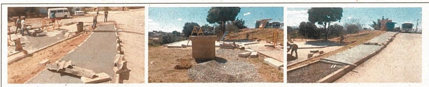
Obras da calçada e colocação de meio fio na Vila Rabelo.
