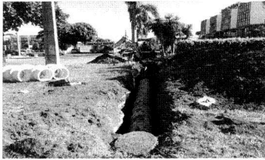
AMPLIAÇÃO DA REDE DE ÁGUAS PLUVIAIS.
