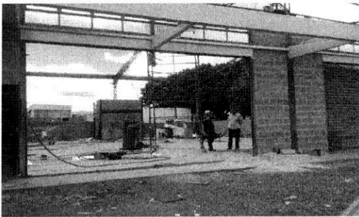
DERRUBADA DE GALPÃO EM ÁREA PÚBLICA.
