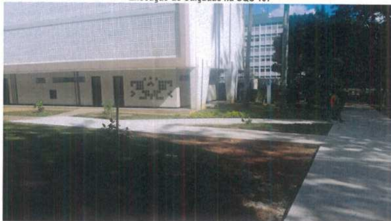
Execução de Calçadas na SQS 107
