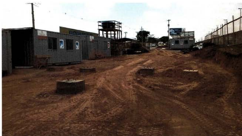
Passarela nº 7 (EPCL) – estacas de fundação (outubro/17)
