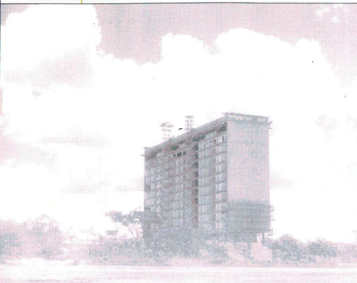
O Hospital Distrital – agora Hospital de Base – em final de construção
