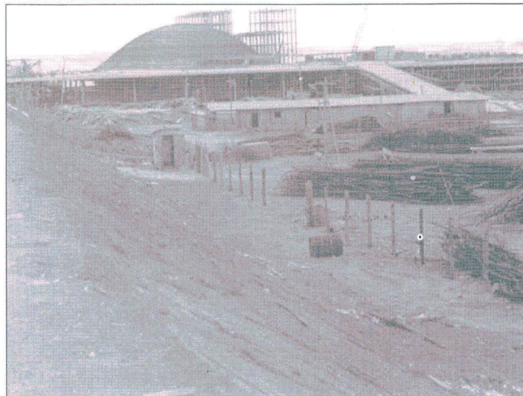
O Congresso Nacional, no início da construção
