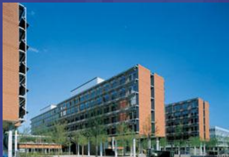
Thomaz Herzog, Edifício administrativo para o Supplementary Pension Fund da indústria SOKA-BAU Wiesbaden
