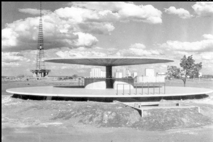
bar e vestiário
