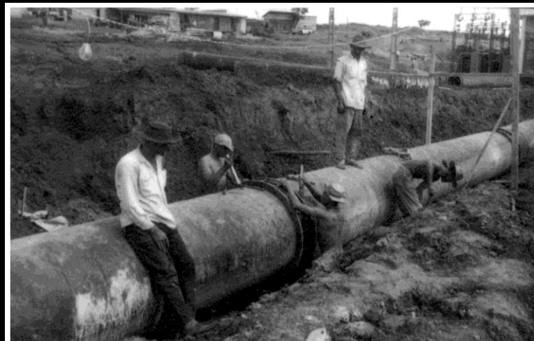
ARQUIVO PÚBLICO DO DF NOV.D.04.04.B.10 Nº 972 CONTEÚDO: CANALIZAÇÃO PRÓXIMO À CASA DE FORÇA DA RPI LOCAL: DISTRITO FEDERAL DATA: [1958-1960] AUTOR: MÁRIO FONTENELLE
