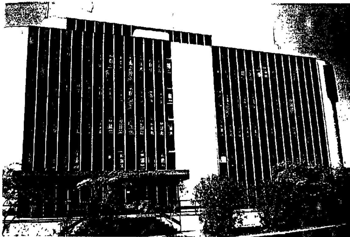
FOTO 1 - SEP/N 515 - BI. A Fachada Principal do Imóvel (W-3)
