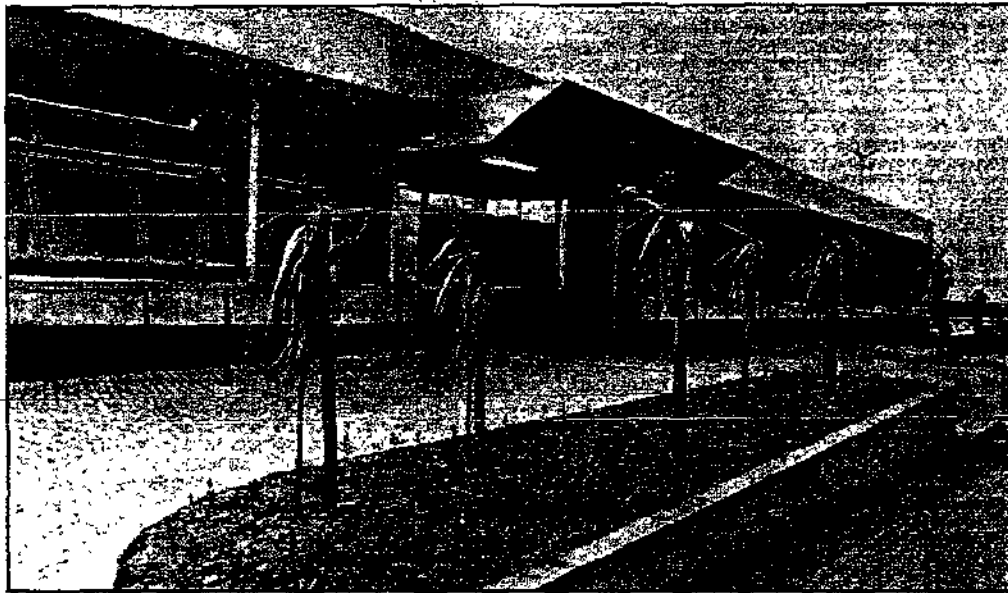
Hospital de Apoio com capacidade para 102 leitos
