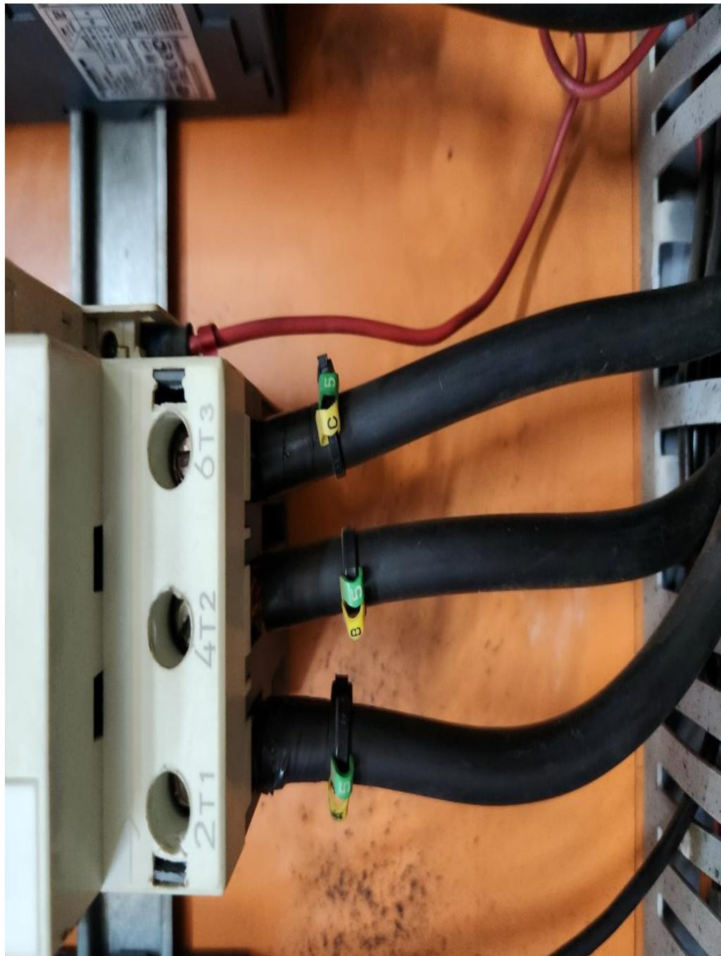
A CLDF possui diversos quadros elétricos equipados com contatoras, dispositivos eletromecânicos cujo ciclo de vida útil é limitado pelo número de atuações/manobras.
