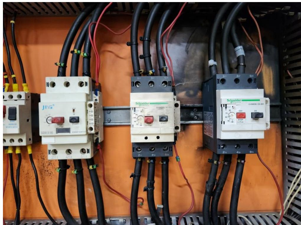
Disjuntores-motores das bombas primárias da CAG: em função de falha ocorrida recentemente, associada ao tempo de operação dos dispositivos e à elevada disponibilidade requerida para esses equipamentos, torna-se necessária a substituição preventiva dos disjuntores, visando assegurar a confiabilidade e a continuidade operacional do sistema.
