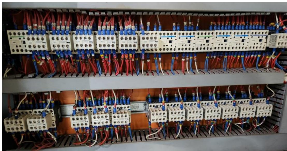
Disjuntores-motores das bombas de condensado da CAG: em função de falha ocorrida recentemente, associada ao tempo de operação dos dispositivos e à elevada disponibilidade requerida para esses equipamentos, torna-se necessária a substituição preventiva dos disjuntores, visando assegurar a confiabilidade e a continuidade operacional do sistema.
