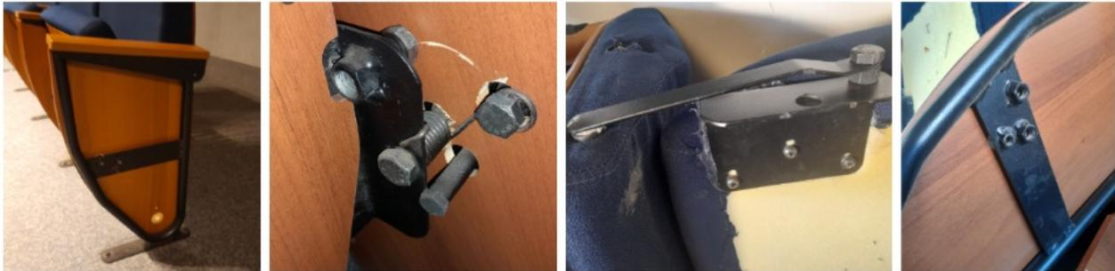
Figura 04 - Detalhes da estrutura metálica, mecanismo e haste de ligação das poltronas com assento rebatível
