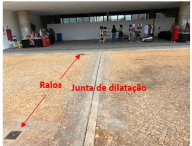
**Figura 02.** Junta de dilatação da laje e ralos pluviais. A construção do pergolado e do novo piso deverá observar a interferência com esses elementos.
