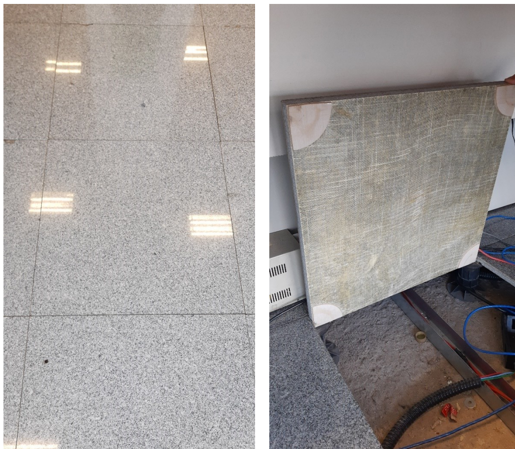
Figura 06 e 07 – Piso flutuante de granito existente na Casa
