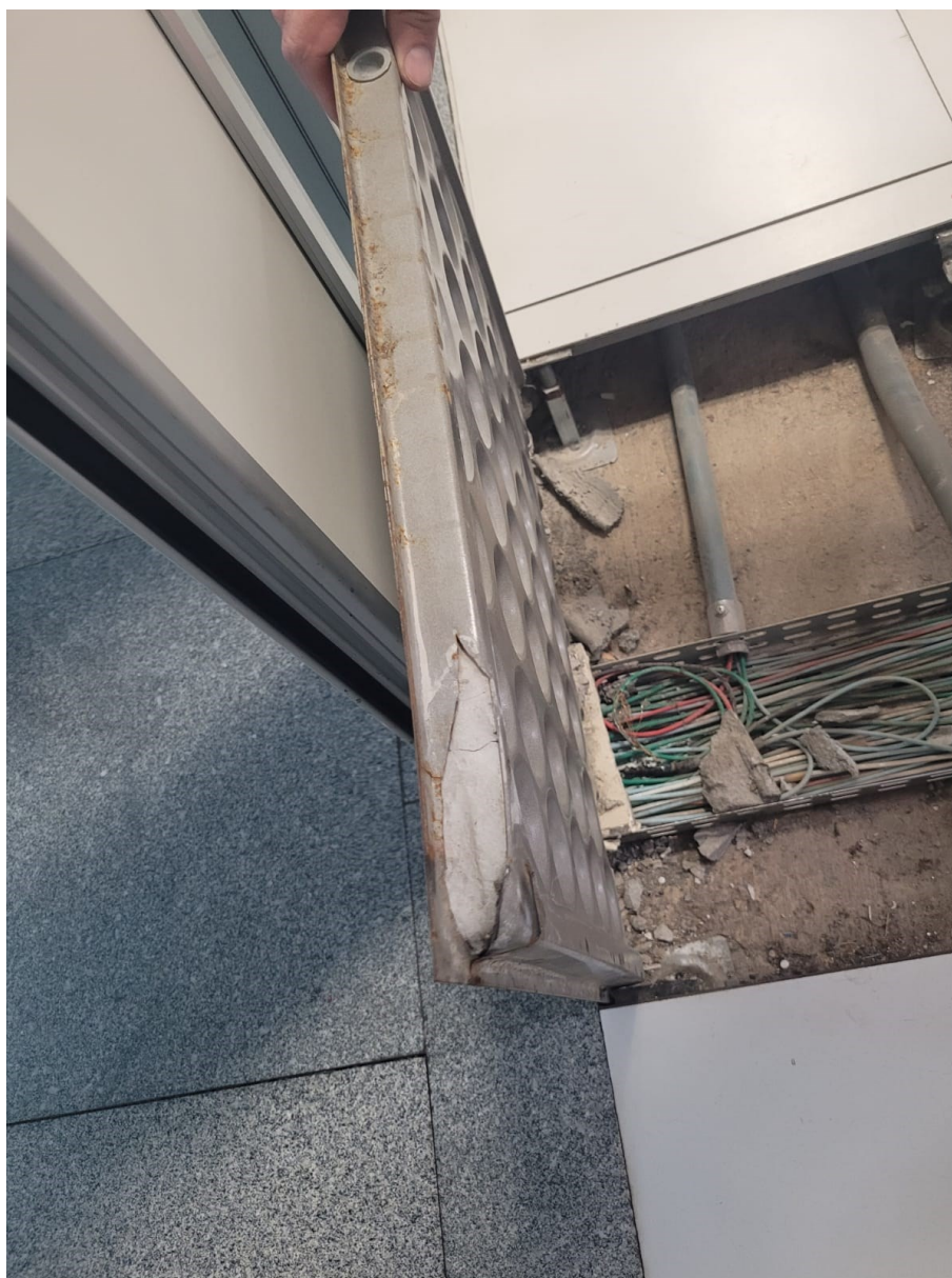
Figura 05 – Situação atual do piso
