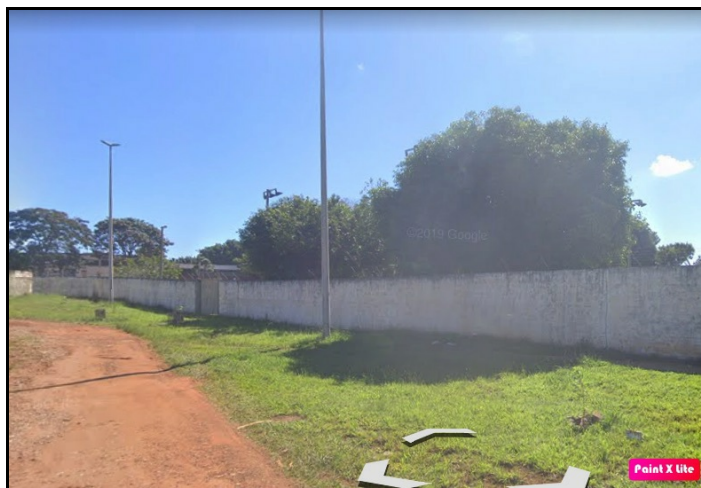
Figura 02: Cercamento por muros das quadras utilizadas pelo Centro de Ensino Médio 01, EQ 18/21, lts 02/03, Setor Leste do Gama. Fonte: GeoPortal/GDF.
