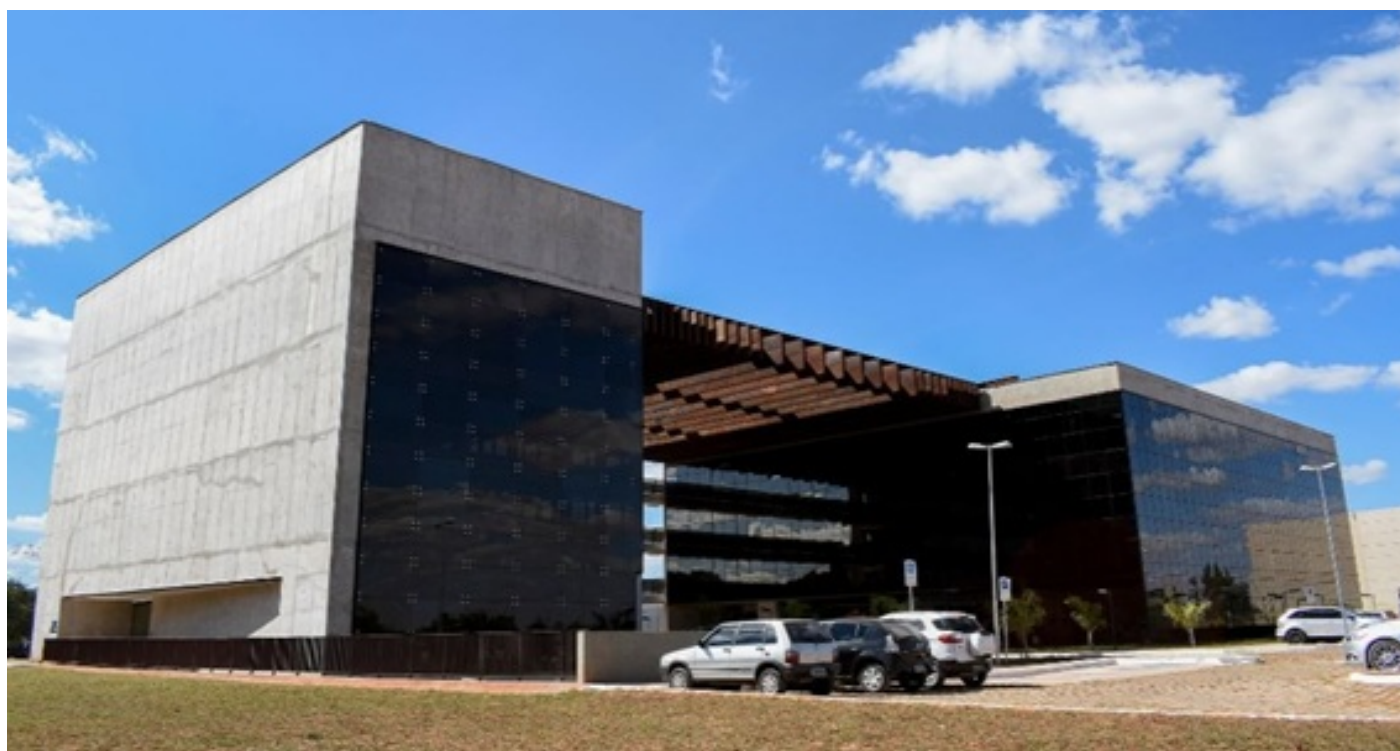
Figura 3. Edifício de Governança do Parque Tecnológico de Brasília BIOTIC, Lote 4.
