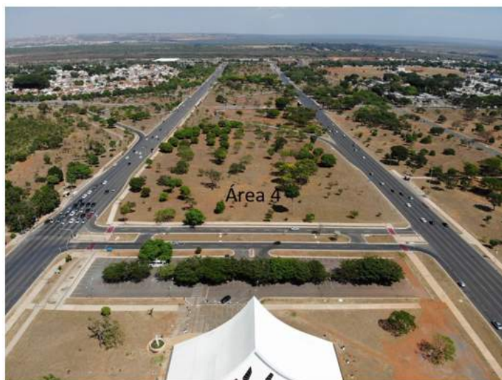
Fig. 11 – Vista aérea da Área 4, sentido oeste.
