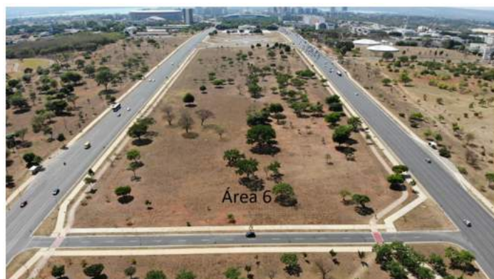
Fig. 16 – Vista aérea da Área 6.
