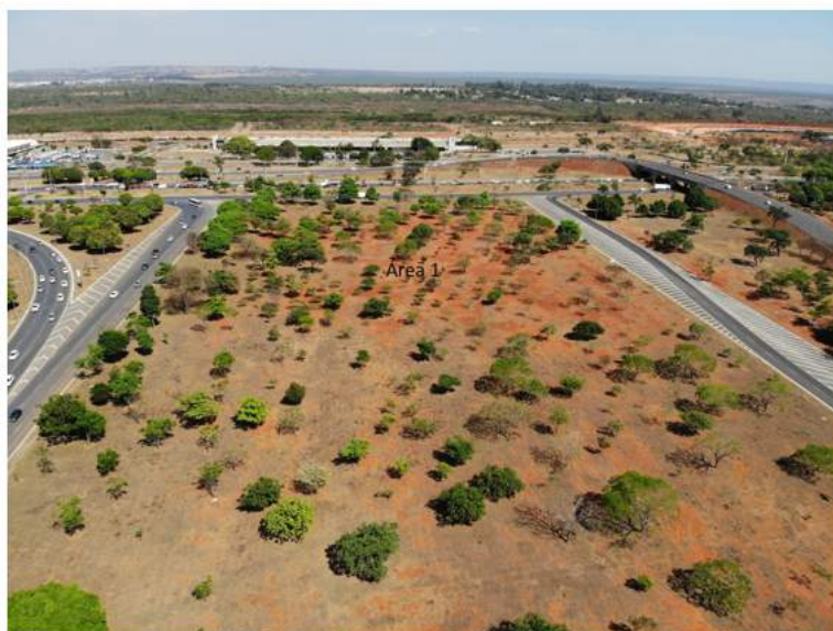
Fig. 2 – Vista aérea da Área 1.
