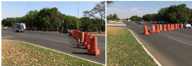
Fig. 5 e 6 – Posicionamento de cones sentido oeste.
