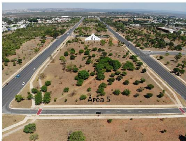
Fig. 14 – Vista aérea da Área 5.
