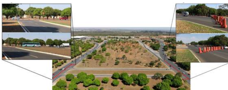
Fig. 3 – Vista aérea da Área 2.
