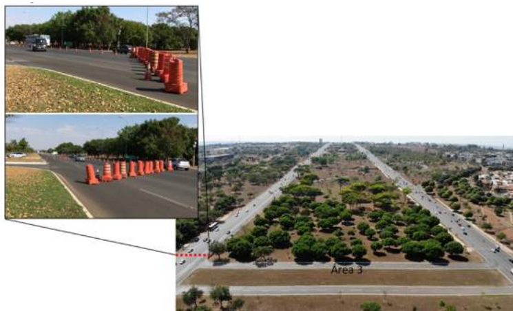
Fig. 9 – Vista aérea da Área 3.
