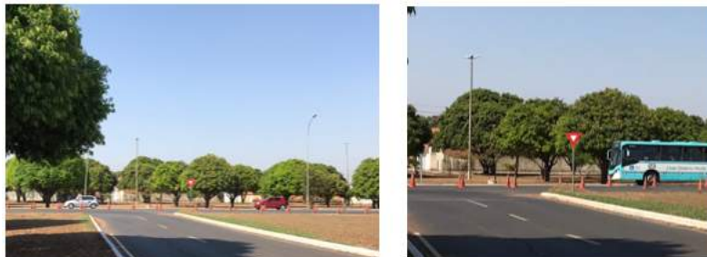
Fig. 7 e 8 – Posicionamento de cones sentido leste.
