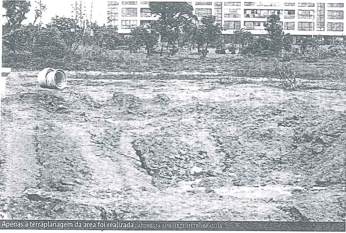
Apenas a terraplanagem da área foi realizada. (ANDRESSA ATHODET/METRO-BRASÍLIA)
