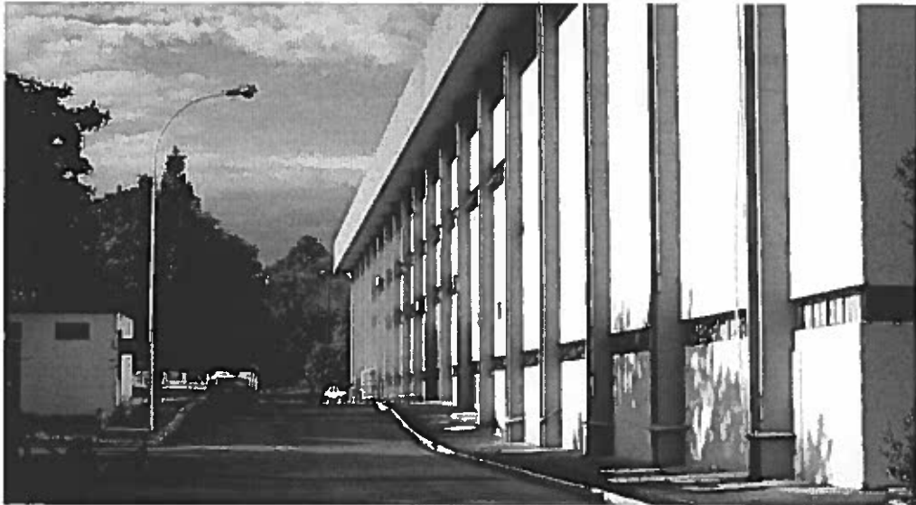
Vista lateral de um dos galpões da GEAB
