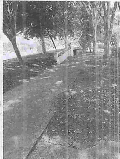
Local 10: Rampa sem corrimão em frente à saída da passagem subterrânea
