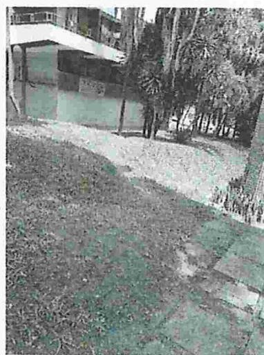
Local 16: Caminho sem calçada e sem proteção entre os blocos C e D da comercial
