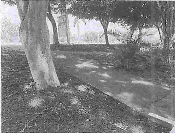
Local 9: Falta rampa acessível entre o bloco H e o eixo L
