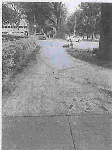
Local 1: Conflito entre calçada e ciclovia
