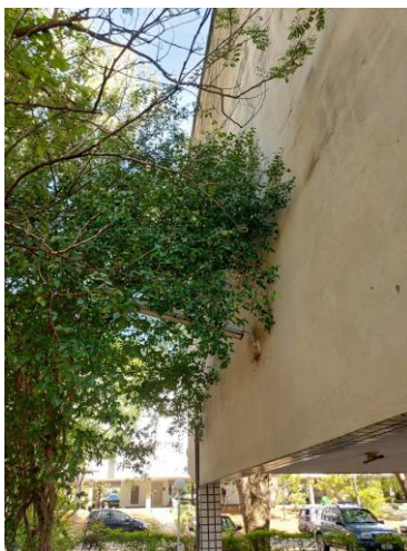
Cobrindo a luminária do bloco
