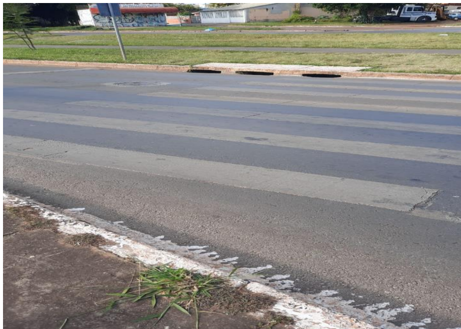
Em Frente a Quadra 21 do Setor Oeste
