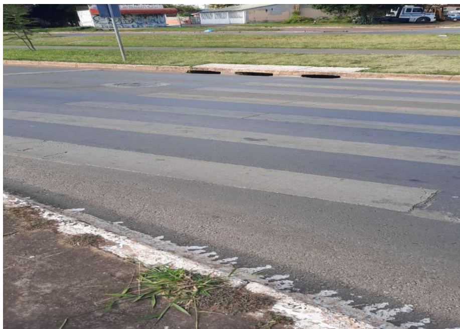
Em Frente a Quadra 21 do Setor Oeste
