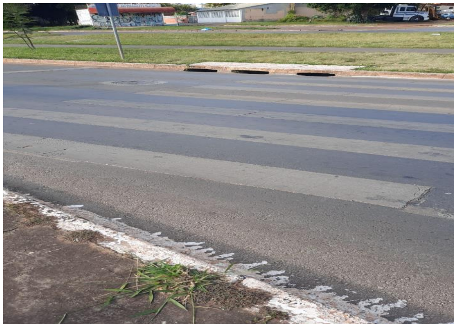
Em Frente a Quadra 21 do Setor Oeste
