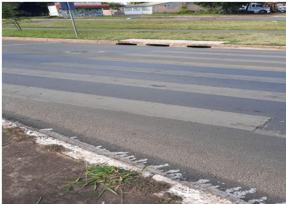
Em Frente a Quadra 21 do Setor Oeste
