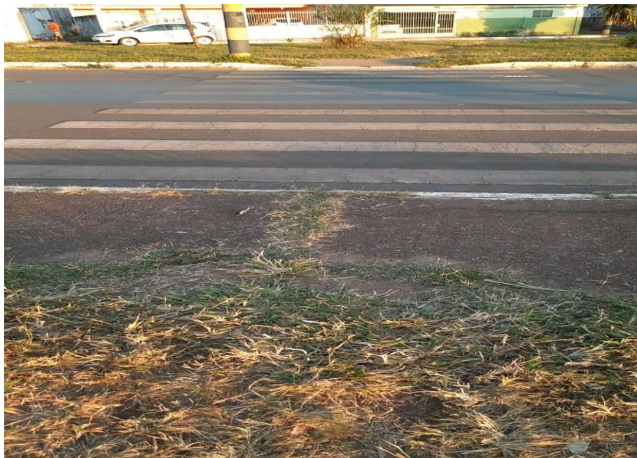
Em Frente a Quadra 03 do Setor Oeste
