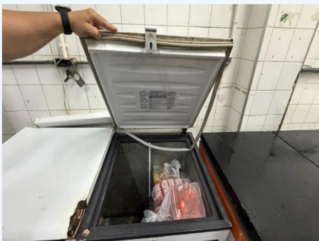
Fotografia 9 – Freezer com danos na porta e na borracha de vedação, sem termostato e termômetro, na área de estoque da cozinha geral do HMIB/SES-DF, Plano Piloto, DF
