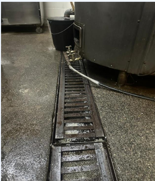
Fotografia 20 – Tela de proteção contra vetores e pragas em grelha de escoamento na área de preparo, cozinha geral do HMIB/SES-DF, Plano Piloto, DF
