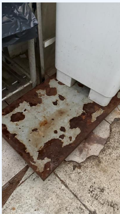
Fotografia 30 – Placa enferrujada na área de higienização de caixas, cozinha geral do HMIB/SES-DF, Plano Piloto, DF
