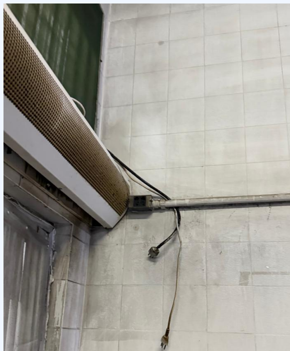
Fotografia 21 – Cortina de ar para proteção contra vetores e pragas desligada na área de preparo, cozinha geral do HMIB/SES-DF, Plano Piloto, DF
