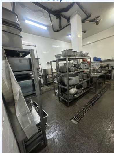
Fotografia 5 – Piso molhado e com revestimento danificado, impedindo a correta higienização, na área de preparo da cozinha geral do HMIB/SES-DF, Plano Piloto, DF
