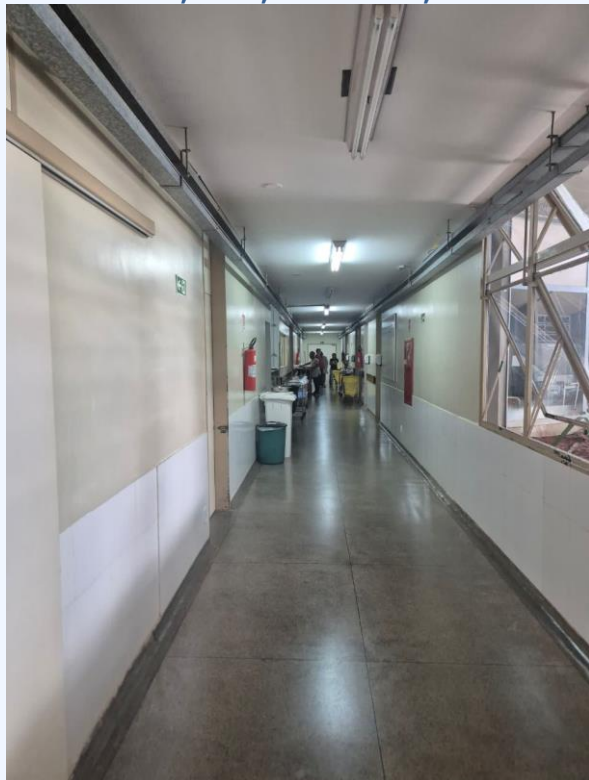
Fotografia 12 – Corredor de acesso à Ala C, HAB, Asa Norte, DF
