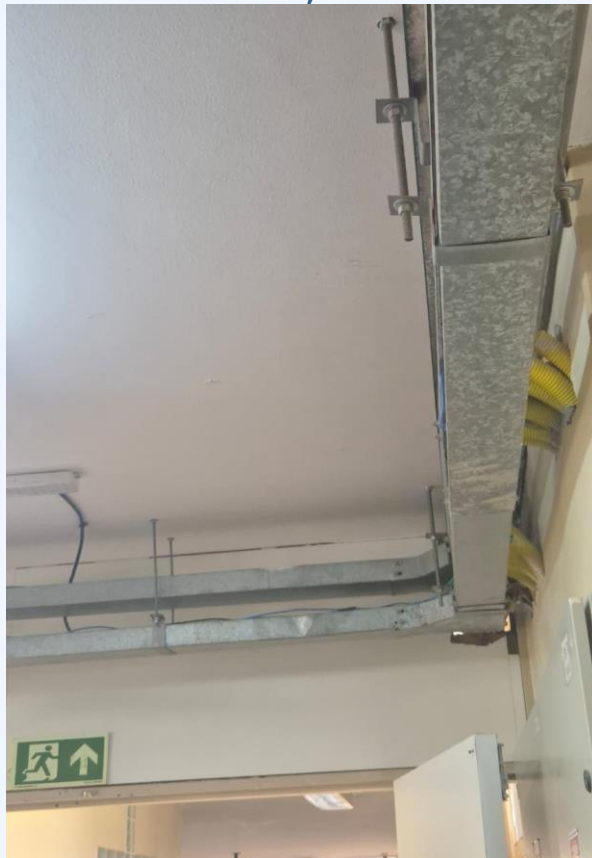
Fotografia 3 – Canaleta para fiação de energia elétrica e lógica, HAB, Asa Norte, DF
