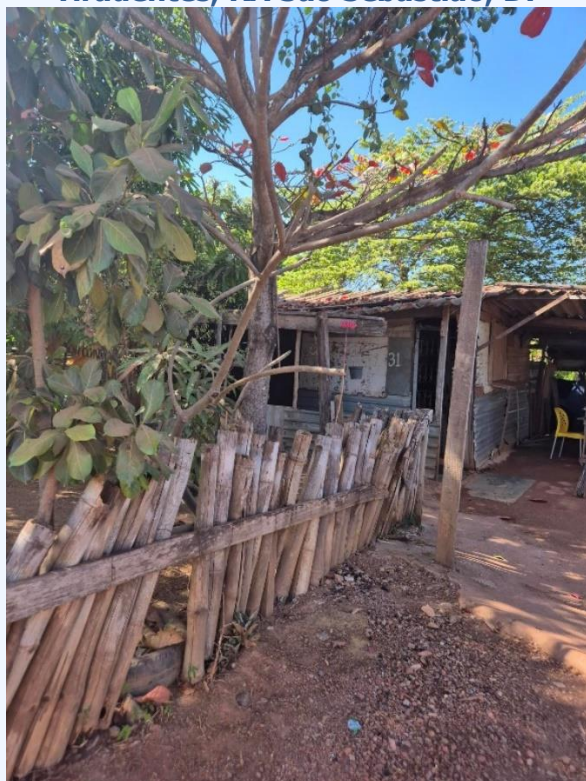
Fotografia 15 – Tipologia construtiva de residência do Assentamento Tiradentes, RA São Sebastião, DF
