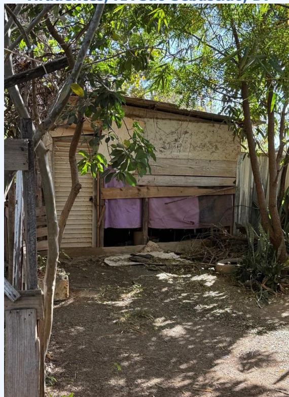
Fotografia 16 – Tipologia construtiva de residência do Assentamento Tiradentes, RA São Sebastião, DF
