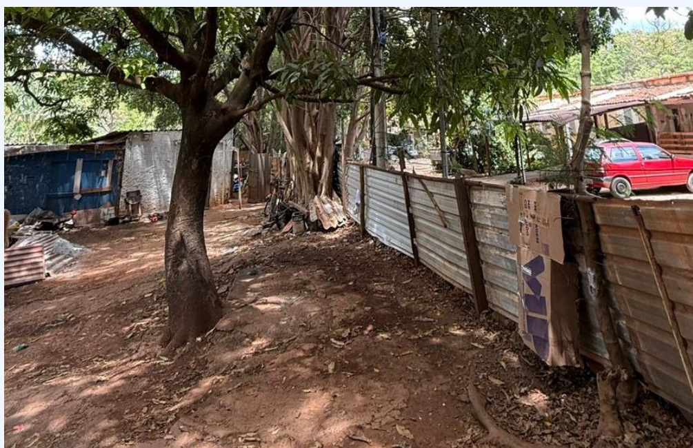
Fotografia 14 – Área sul da Vila Cultural Cobra Coral, Asa Sul, RA Plano Piloto, DF, com predominância de unidades residenciais construídas com vedações em madeira, material reaproveitado, placas de madeirite compensado, placas de alumínio e papelão
