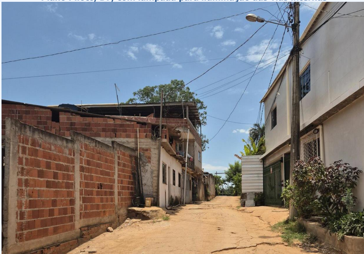
Fotografia 11 – Poste de energia elétrica na Vila Cultural Cobra Coral, Asa Sul, RA Plano Piloto, DF, com lâmpada para iluminação das vias internas
