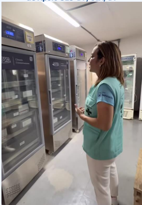
Fotografia 6 – Câmaras refrigeradas para armazenamento de materiais de laboratório no GADMLAB, do Parque de Apoio SES-DF, SIA, DF
