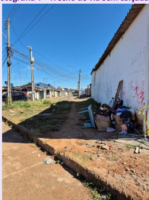
Fotografia 1 - Trecho de via sem calçadas
