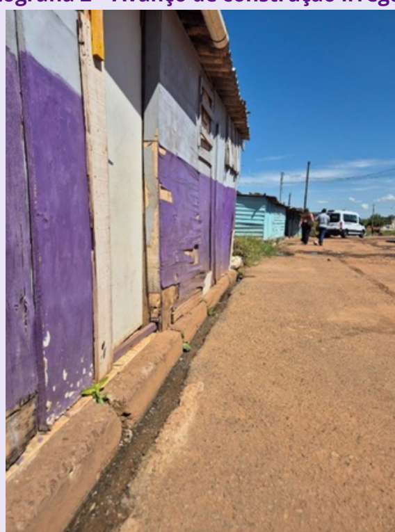
Fotografia 2 - Avanço de construção irregular
