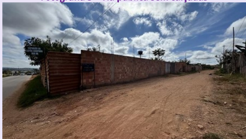
Fotografia 3 - Via pública sem calçadas
