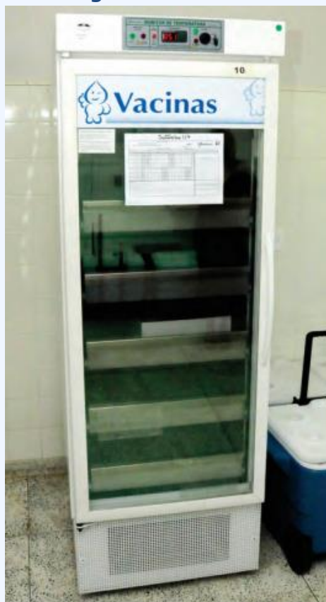
Figura 5 – Modelo de câmara refrigerada utilizada para armazenamento de imunobiológicos na rede de frio
