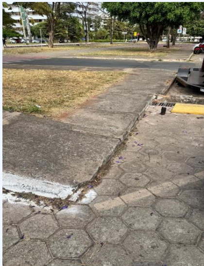
Fotografia 4 – Calçada com rampa de acessibilidade fora do padrão normativo – RA Sudoeste
