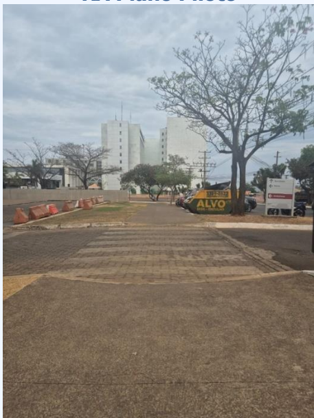
Fotografia 19 – Calçada da CLDF com desnível, sem rampa de acessibilidade, RA Plano Piloto
