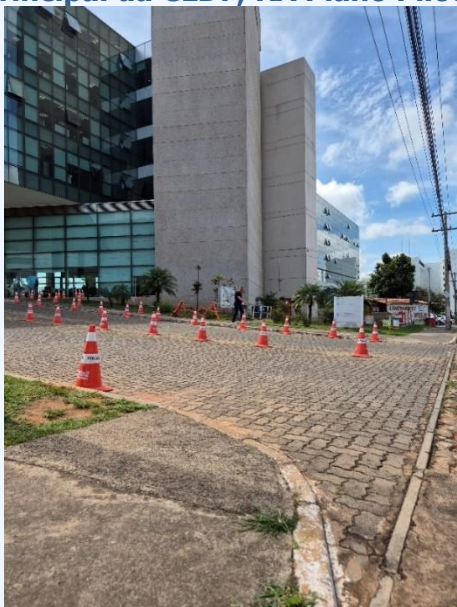
Fotografia 17 – Calçada, à esquerda, com desnível sem rampa de acessibilidade para acesso à recepção principal da CLDF, RA Plano Piloto
