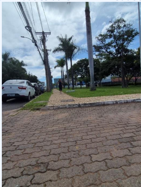
Fotografia 14 – Calçada com desnível, sem rampa de acessibilidade nas proximidades da CLDF – RA Sudoeste
