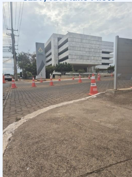
Fotografia 18 – Calçada, à direita, com desnível sem rampa de acessibilidade para acesso à recepção principal da CLDF, RA Plano Piloto
