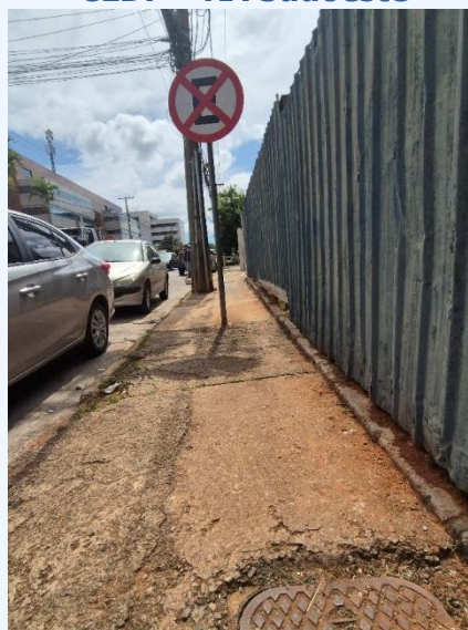
Fotografia 12 – Calçada com desnível, sem rampa de acessibilidade e com obstáculos à livre circulação nas proximidades da CLDF – RA Sudoeste
