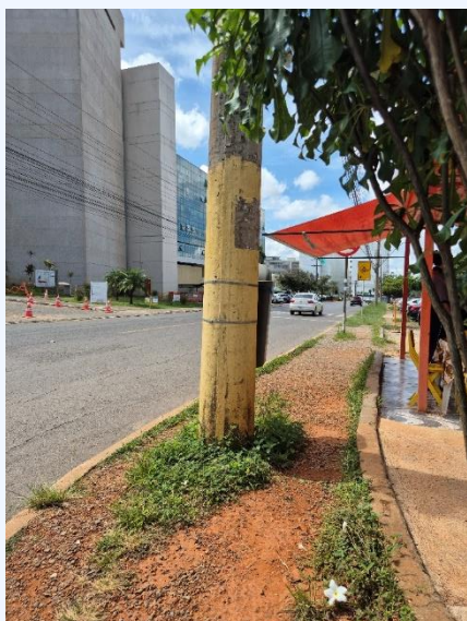
Fotografia 11 – Calçada com desnível sem rampa de acessibilidade e com obstáculos à livre circulação nas proximidades da CLDF – RA Sudoeste
