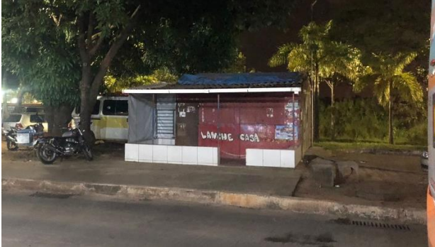
Figura 28 – Quiosque de lanche no entorno do Terminal Fonte: Autoria própria
