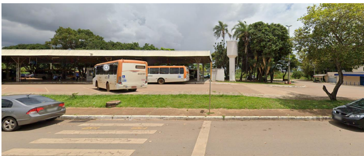
Figura 14 – Ausência de rebaixo do meio-fio, descontinuidade da travessia por falta de conexão das calçadas Fonte: Google Maps
