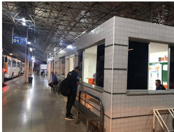
Figura 30 – Sala de apoio Fonte: Autoria própria
