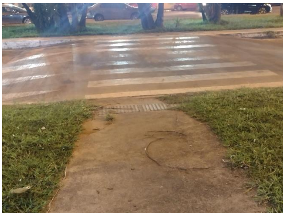
Figura 10 – Travessia em nível dando acesso ao Terminal Fonte: Autoria própria
