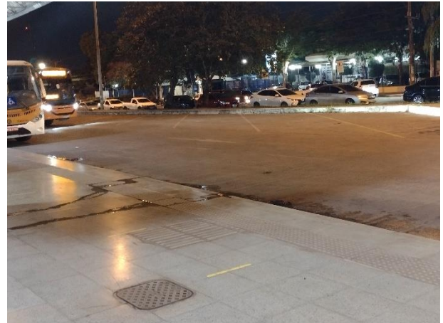
Figura 25 - Água escorrendo próximo ao Box 4 Fonte: Autoria própria
