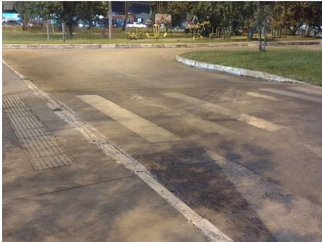
Figura 15 – Travessia elevada com piso tátil de alerta Fonte: Aatoria própria
