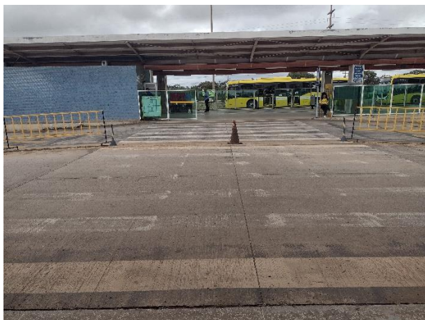
Figura 21 – Travessia elevada entre plataformas Fonte: Autoria própria
