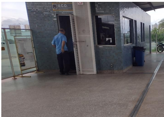
Figura 35 – Unidade de Controle de Operação - U.C.O.
