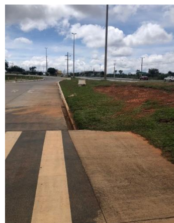
Figura 16 – Ausência de calçada conectando o entorno imediato do Terminal com as calçadas nas proximidades Fonte: Autoria própria
