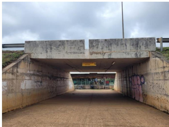
Figura 14 – Passagem de acesso ao Terminal Fonte: Autoria própria
