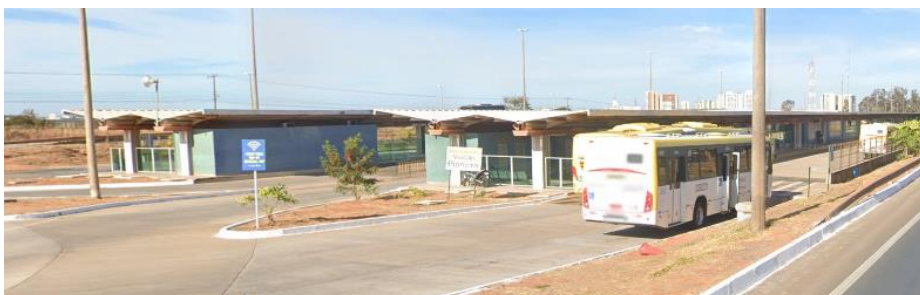
Figura 1 – Vista do Terminal sentido Gama
