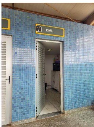
Figura 5 – Sala sinalizada como DML usada como copa
