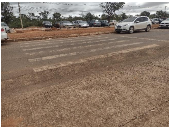
Figura 13 – Rebaixo do meio fio na travessia apenas no lado do entorno imediato do Terminal Fonte: Autoria própria
