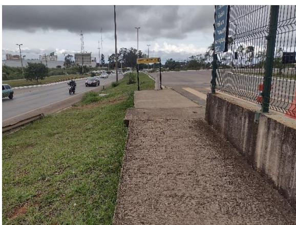
Figura 17 – Área de manobra estreita para cadeirante e sem proteção contra o desnível Fonte: Autoria própria
