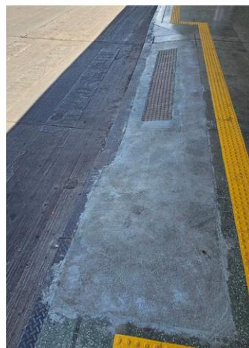
Figura 18 - Travessia de pedestre com rampa acessibilidade.
