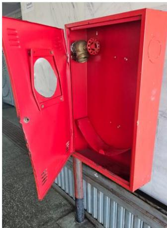
Figura 10 - Caixa de Hidrante sem mangueira.
