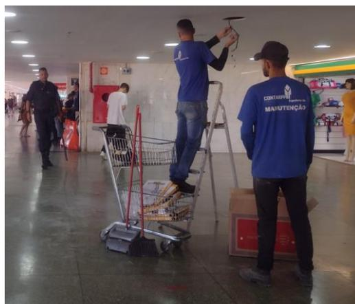
Figura 31 - Funcionários da empresa CONTARPP substituindo luminárias.
