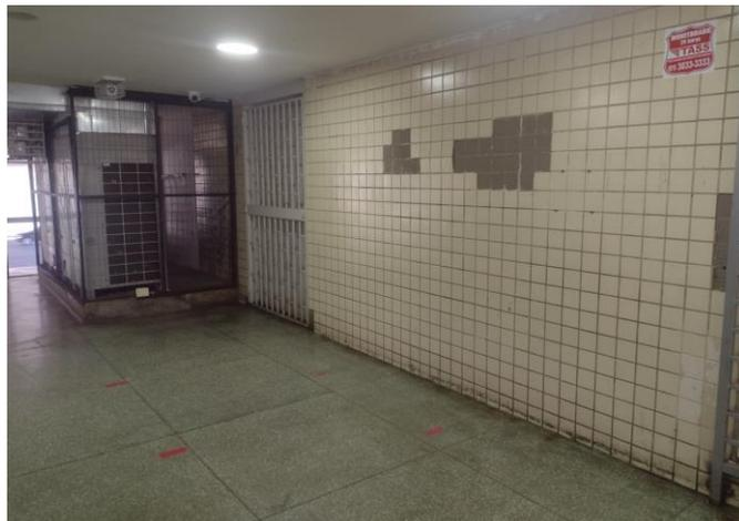
Figura 30 - Paredes do mezanino com deslocamento de revestimento.
