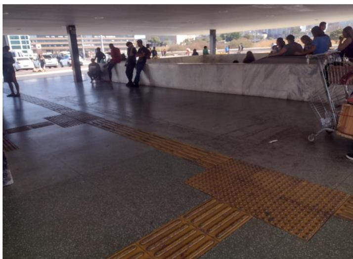
*Figura 4 - Sinalização horizontal por piso tátil no piso superior.*
