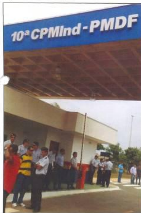
A construção da 10ª CPMind é resultado da conquista de um plano de obras que inclui a padronização de todas as unidades da PM.
