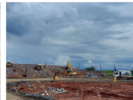
Aterro sanitário de Brasília
